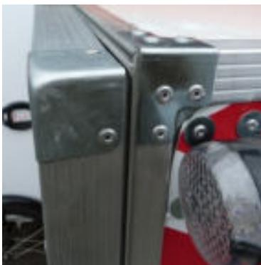
9. **Mangelbeschreibung:** Tür der Box muss zum Verschließen angehoben werden. Bei der regulären Zustellung wird dies nicht durchgeführt, da hierzu die Tür mit zwei Händen bedient werden müsste. Hierdurch läuft Wasser in die Box und beschädigt die Pakete. Des Weiteren sammelt sich das Wasser beim korrekten Verschließen der Box im oberen Türbereich. Dieses Wasser läuft beim Öffnen in die Box und beschädigt ebenfalls die Sendungen.
