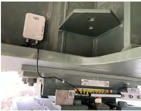
Überwachung eines kritischen Brückenabschnitts mit umfangreicher Sensorik
