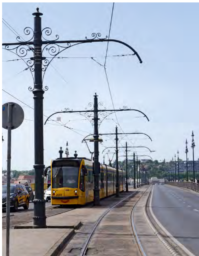
Abb. 3: Filigrane Fahrleitung auf der historischen Margarethenbrücke in Budapest, Foto: U. v. Stockhausen
